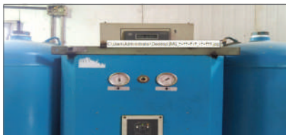
نمایشگر مقدار نقطه شبنم هوای خروجی (که باید از منفی ۸۰ درجه سانتی گراد کمتر باشد)
